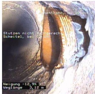
Abbildung 25: Schäden durch oder an seitlichen Anschlüssen
