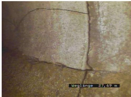
Abbildung 27: Beschädigte Kanalisationsleitung
