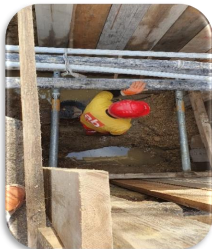
Kanalisationsanschluss an Leitung AIB 2 Brückenquerung
