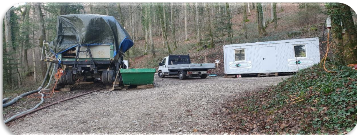
Installationsplatz 2. Bohrung durch Innerstoffdeponie
