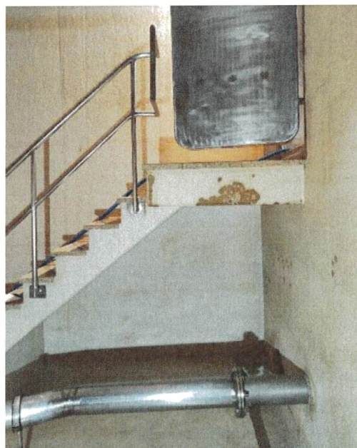
Abb. 9: Kammer 1 Erweichte / Verwitterte Beschichtung (Ecken und Treppe)
