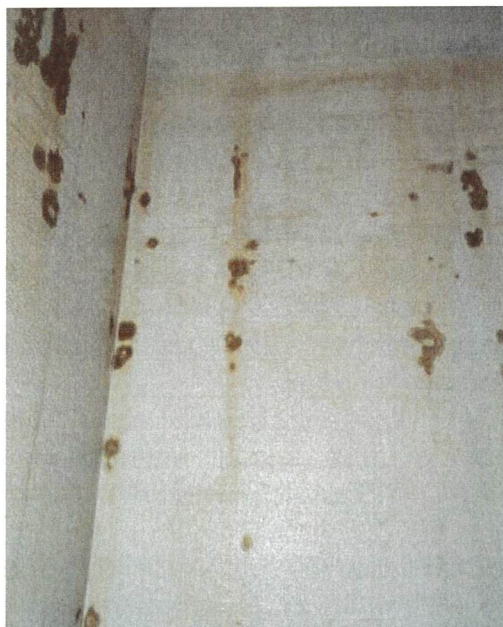
Abb. 9: Kammer 1 Erweichte / Verwitterte Beschichtung (Ecken und Treppe)
