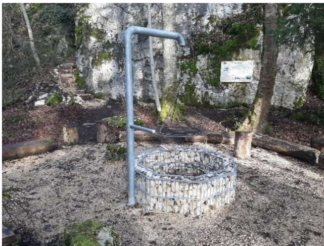
Grillstelle nach der Fertigstellung
